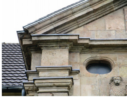
Verblechung von Giebel und Gesimsen
