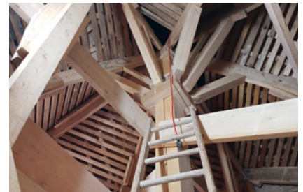
Konstruktion des Lehrgerüsts
