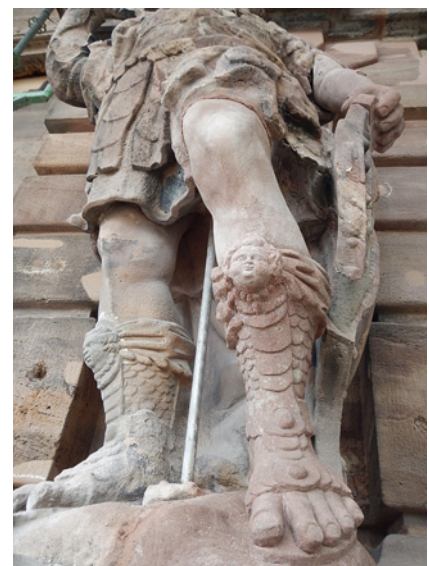
Ergebnis nach Einbau und Nachbehandlung Fotos: Monolith Bildhauerei u. Steinrestaurierungs GmbH
