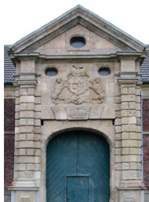
Ansicht des Hauptportals vor (links) und nach den Maßnahmen (rechts)
