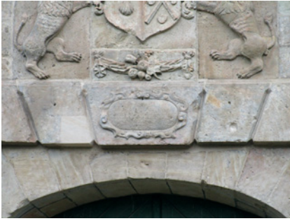
Vierungen im Bereich des Torbogens
