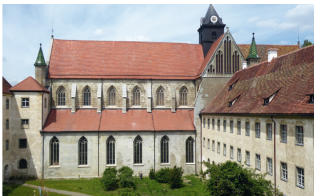
Ansicht Südfassade und Giebel gesamt Endzustand
