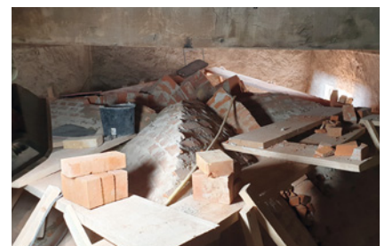
Vollständig geschlossene Gewölbekappen Fotos: Sauer GmbH
