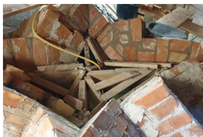
Scheitelpunkt der Gewölbekappen vor dem Schließen
