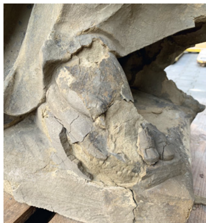
Figur Frankonia, Schadensbild rechter Fuß
